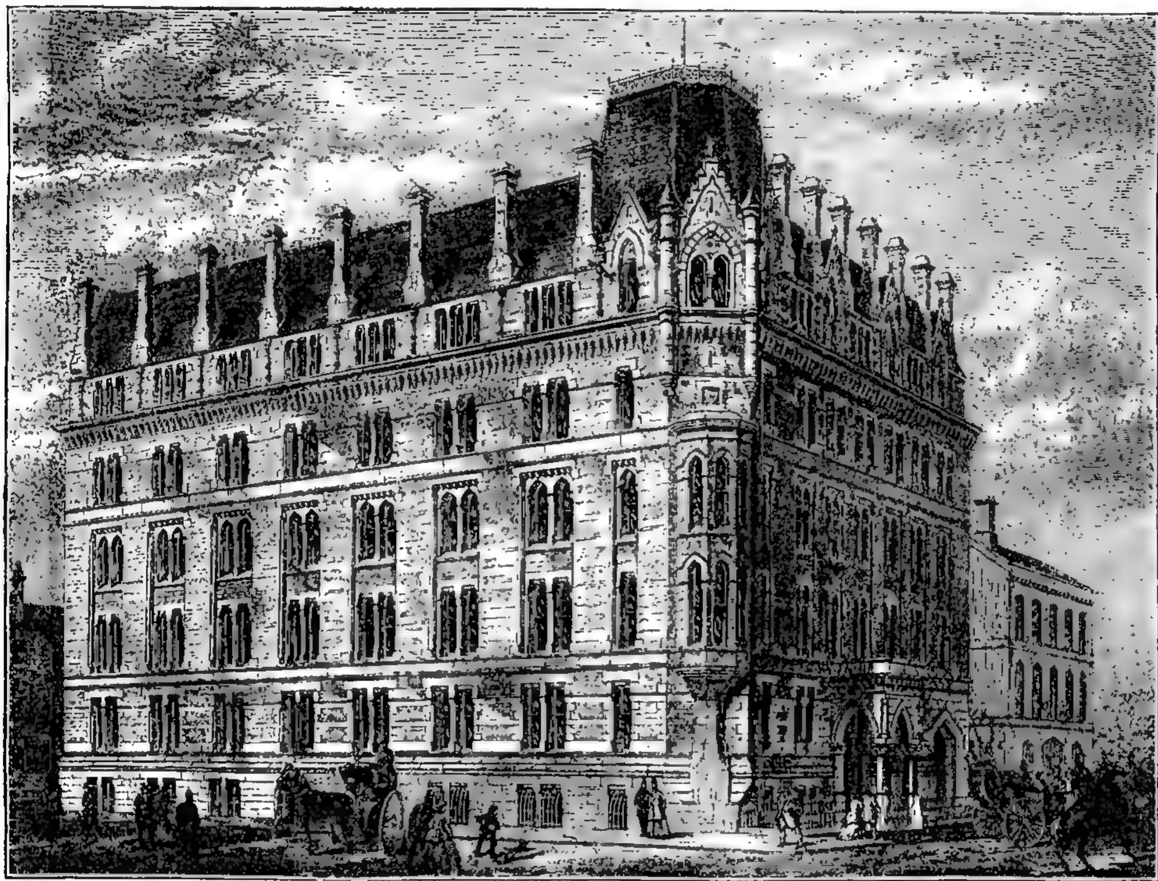
230. Товарный складъ въ Манчестерѣ, построенъ Т. Ворthingтономъ. По „The Builder“.
